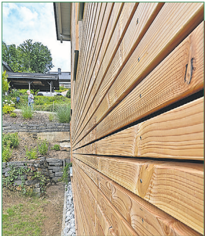
Schutz: Die Rautenschalung ist ein Wetterschutz, der durch offene Fugen weiterhin die Luft ans Mauerwerk lässt.
