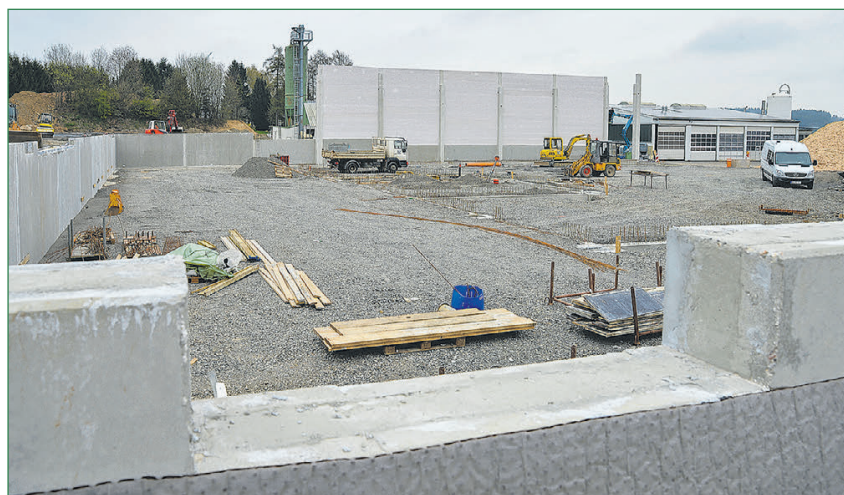
Baustelle: Um-, Aus- und Neubauten gab es ständig. So wie hier 2017, als eine neue Spänehalle sowie das Gebäude für die SEO-Sägeanlage errichtet wurden.
