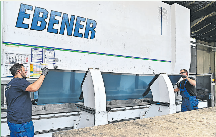
Vorbereitung: Daniel (links) und Lukasz kanten Bleche ab, die später in Fassaden verbaut werden.
