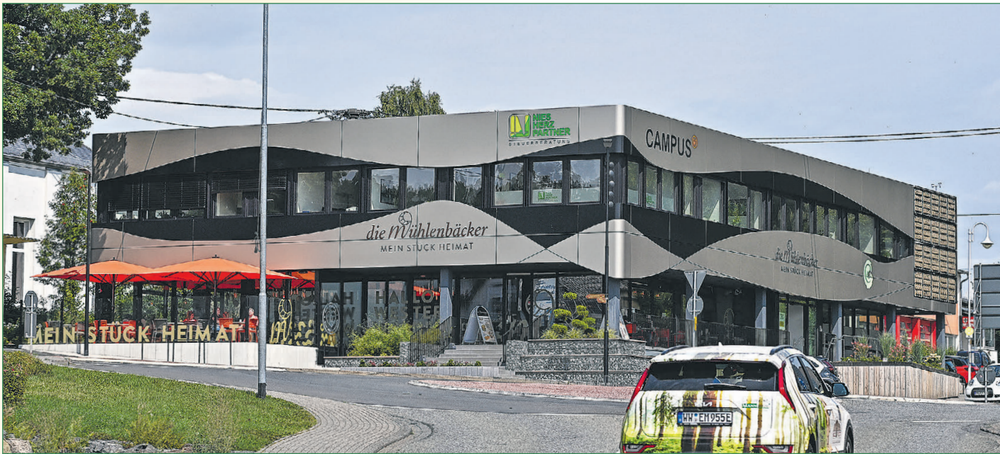
Bauwerk: Das „Campus“-Gebäude in Bad Marienberg hat ebenfalls eine Aluminium-Fassade von Ebener erhalten.
