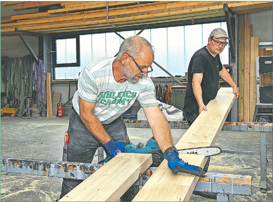
Einzelteile: Thomas Marschang (links) und Justin Oberschmied fertigen in der Werkstatt die vielen Elemente an, die der WHB für einen Holzrahmenbau benötigt.
